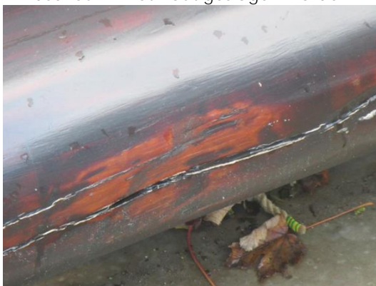
Figuur 5.11: Verkleuringen nabij een windscheur
