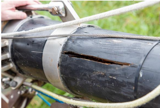
Figuur 5.10: Meten van de diepte van tegenover elkaar liggende windscheuren
