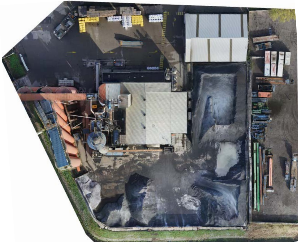
Afbeelding 1, luchtfoto locatie Eurogrit
