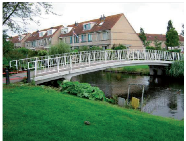
Valckslootlaanbrug, Hillegom (gemeentelijk) Bouwjaar 1971 Betonnen liggers, overspanningen 11,5 m. en 2 x 2,5 m.
