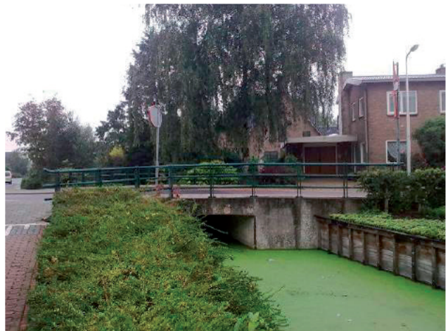
Schoolstraat, Bergambacht (gemeentelijk) Bouwjaar 1955 Betonnen plaat met betonnen keerwanden op houten palen
