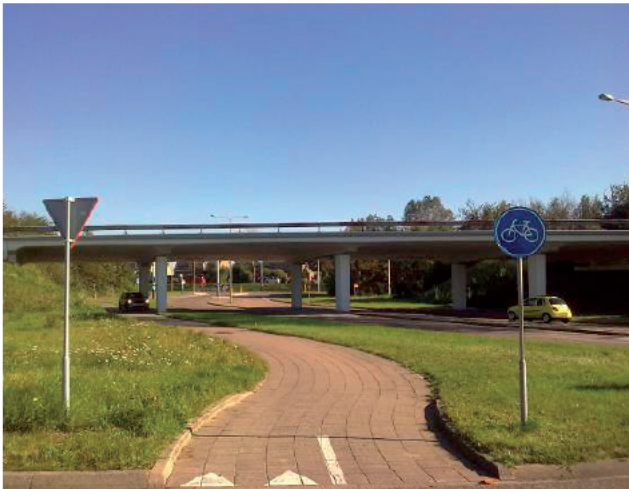
N206/Herenweg, Noordwijkerhout (provinciaal) Bouwjaar 1964 Viaduct, betonnen plaat, 4 overspanningen ca. 10 m.
