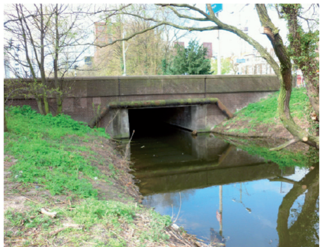
Brug 85, Den Haag (gemeentelijk) Bouwjaar 1931 Betonnen plaat met stalen hoofdliggers
